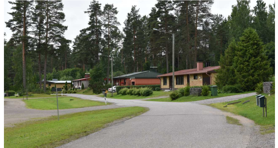
Kuva: Rakennusliike Niirasen Ky:n suunnittelema pien- ja rivitaloalue 1970-luvulta. Kaarevan Aaronkadun omakotitalot ovat ajalleen tyypillisiä yksikerroksisia ja syvärunkoisia pientaloja, joissa on loiva harjakatto ja valesokkeliperustus. Julkisivuissa on käytetty vaihtelevalla tavalla joko yhtä tai useampaa verhouksmateriaalia tai -tapaa.
